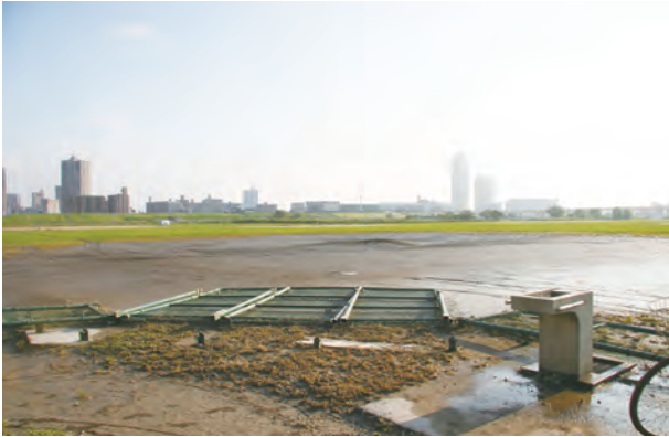
平成 19 年 9 月台風被害（冠水後）
