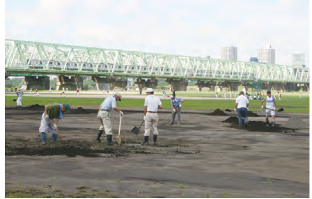
冠水による汚泥除却作業
